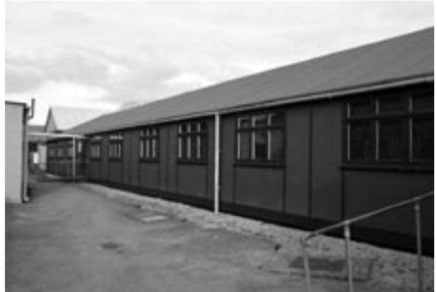
La «Baracca 8» come appare oggi, dopo l'accurato restauro effettuato nel corso dell'allestimento del museo di Bletchley park (foto autore).
