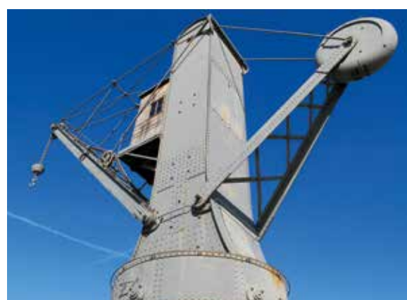
La gru idraulica Tannet & Walker, da dieci tonnellate di tiro, situata accanto al "Bigo". In alto, a destra, gru a mano da banchina collocata davanti al Museo "Galata". A sinistra, carico del carbone fino all'imbocco dei carbonili sulla fiancata della nave.
